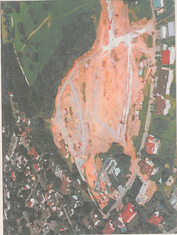
Die Erschließung des Wohngebietes „Auf Eggen“ befindet sich in der Endphase. Der Bau eines Hauses hat bereits begonnen. Foto: Firmenfoto Bebauung, die Interessenten abschrecken sollten, änderten an der Nachfrage nichts. Längst haben die intensiven Untersuchungen des Geländes inzwischen die Unbedenklichkeit einer Wohnbebauung „Auf Eggen“ ergeben.
